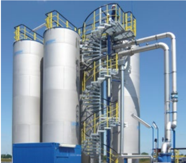
Quelle: DynaSand-Filter von Nordic Water
