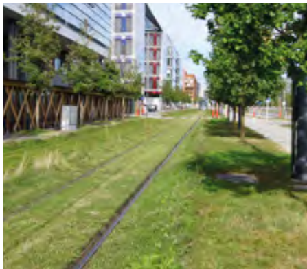
Création de rails végétalisés avec herbe
